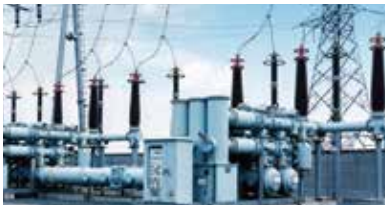
| 35~500kV | 将发出的电能进行升压到系统电压
